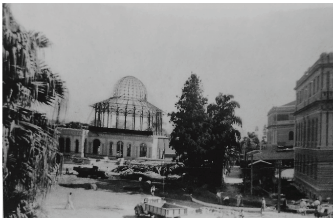
Figura 14. A demolição do Jardim da Infância, no início de 1939
