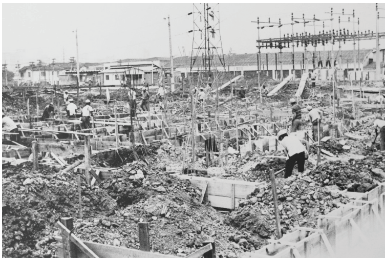
Figura 5. Construção do Prédio da ETFSP – Década de 1960.
