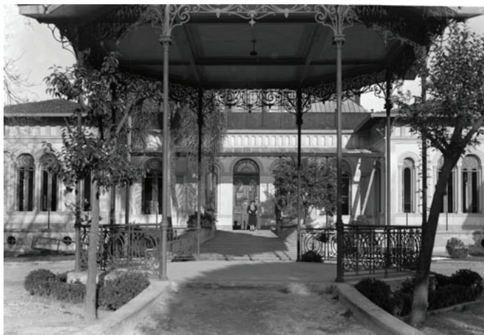
Figura 8. Pavilhão do Jardim da Infância
