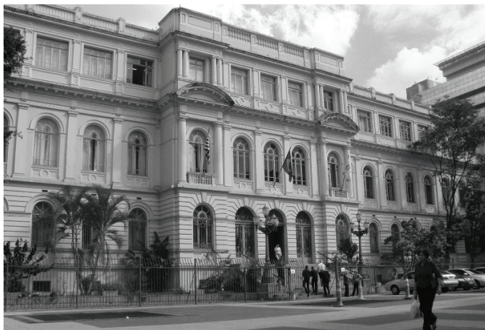
Figura 5. Escola Normal de São Paulo com o terceiro pavimento instalado
