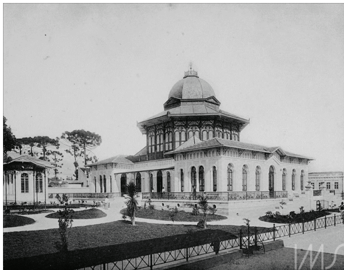
Figura 6. Prédio do Jardim da Infância, inaugurado em 16/02/1897
